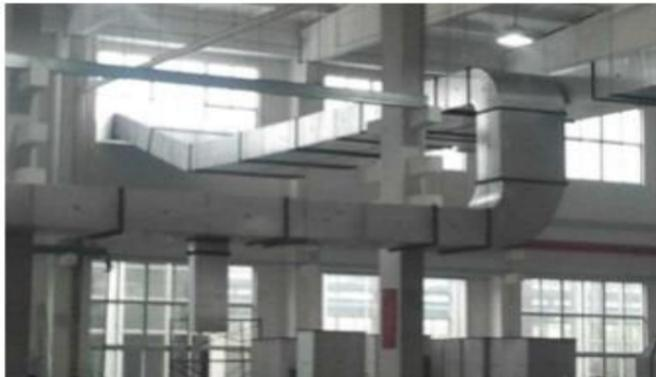
通风空调管道系统的阻力问题关乎工业建筑安全生产（加速管壁磨损），还可诱发动气噪声污染、增加管道积灰及有害微生物沉积、引起风机喘振等，引发事故。
