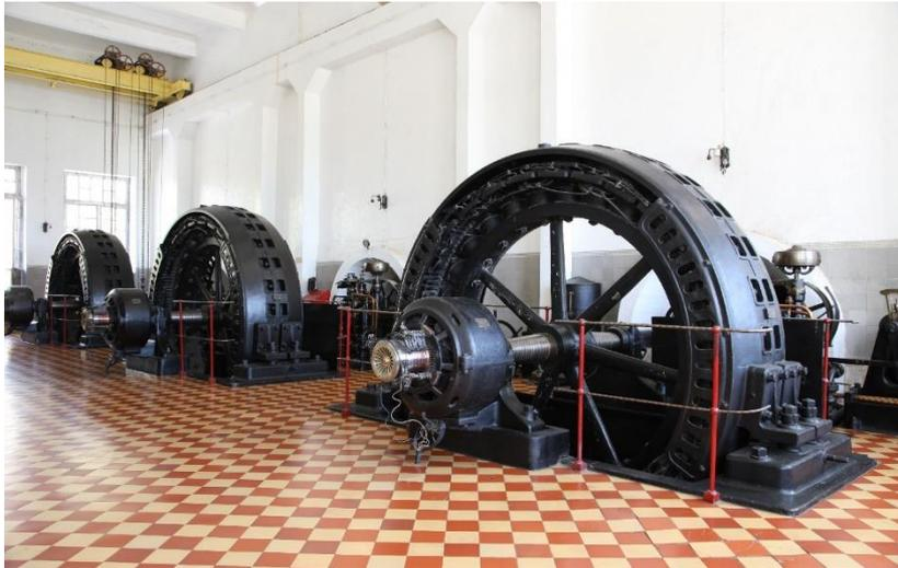
Гиндигушская ГЭС введена в эксплуатацию в 1903 году. Установлено 3 гидротурбины. Суммарная проектная мощность электростанций 1200 кВт. В настоящее время все оборудования находится в эксплуатации
