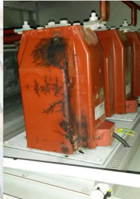
*Se produjo una explosión en la cabina del interruptor del switchgear, activando las protecciones (RECLOSER) de la planta.*
