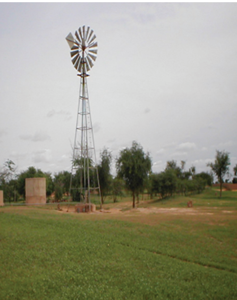
Système éolien de pompage d'eau dans le village de Chikal Courtoisie: Ministère de l'Energie et du Pétrole du Niger
